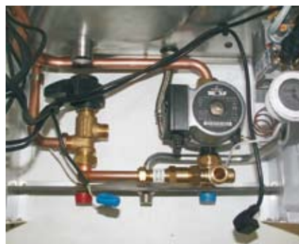
demontáž pripájacieho bloku
