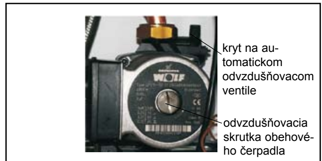
automatický odvzdušňovací ventil na obehovom čerpadle
