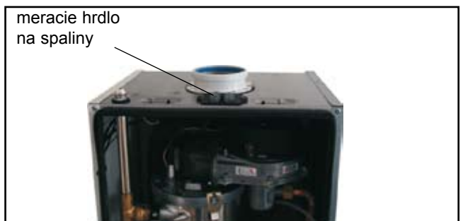
meranie spalín na kotle bez plášťa
