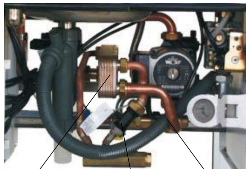
doskový výmenník senzor prietoku rozdeľovací blok
